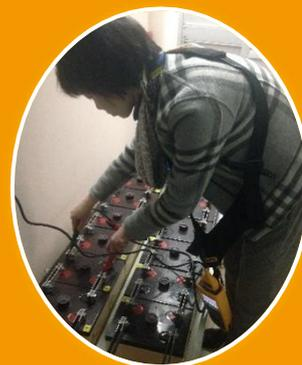
通过BT510对基地、机房多组电池的测试，南方两省市的通讯公司对福禄克的手持式蓄电池内阻测试仪的测试速度、精度、测试结果可靠性都非常认可。
