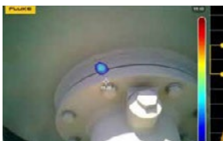
SF6 绝缘气体法兰连接处泄漏
