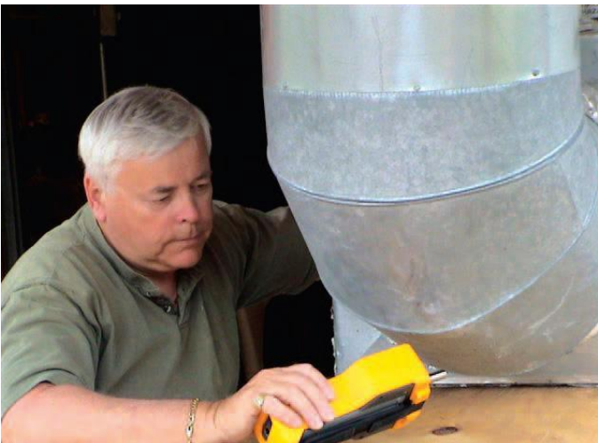
测试回流管和空调管道内的污染物，说明存在泄漏或其它设备故障。
