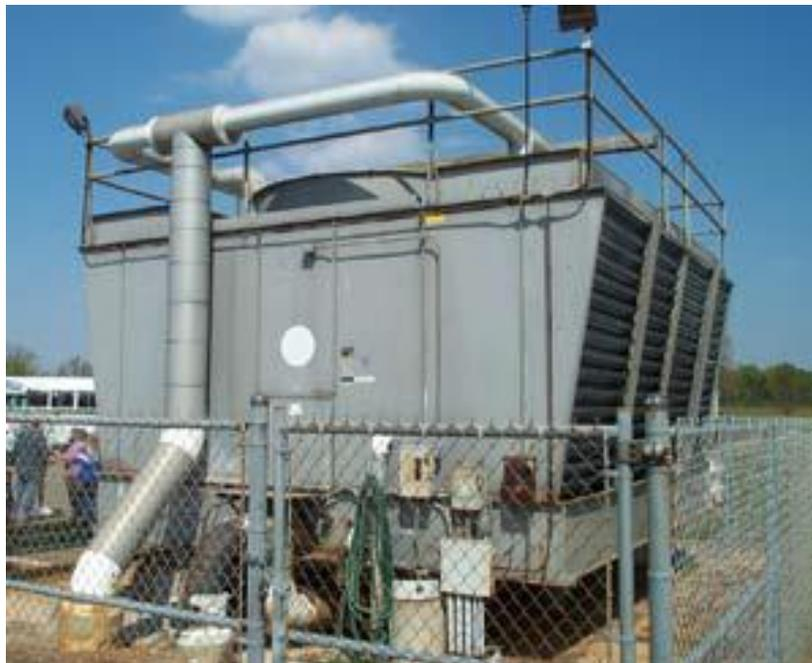
必须对冷却塔风扇电机的绝缘和绕组进行测试。
